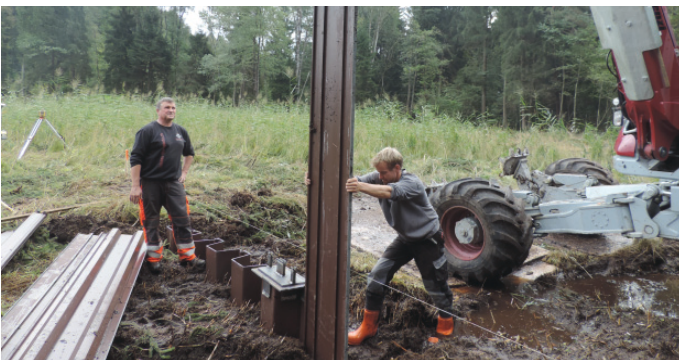
Einbau einer Spundbohle
