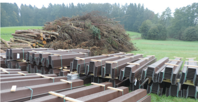
Spundbohlen- und Holzlager an der Kreuzstrasse
