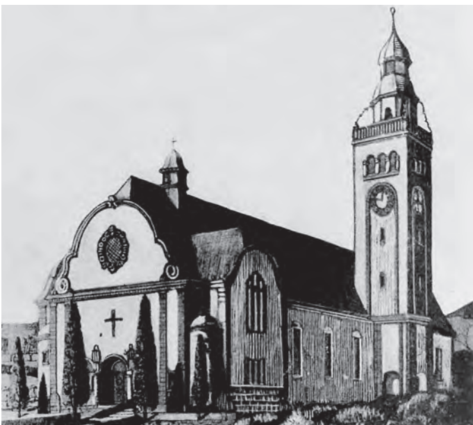
Renovierte Kirche mit neuem, 42m hohem Kirchturm
