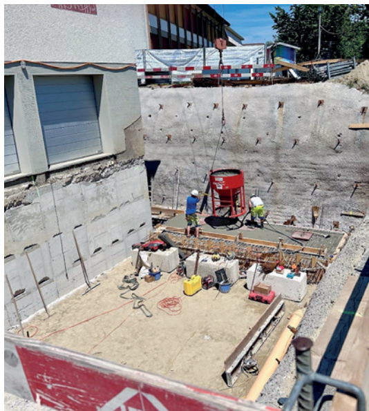
Der Schnitzelbunker wird betoniert.
